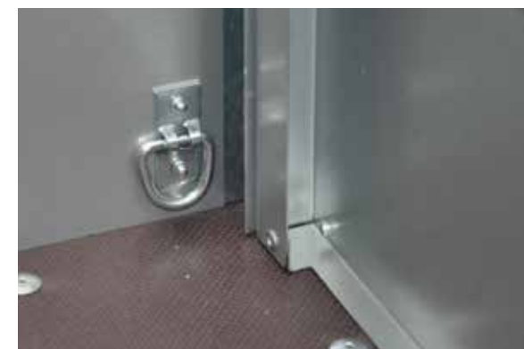
vier aan de zijwanden bevestigde aansluitingen
